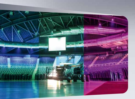
Nun wurde auch die Volkswagen-Halle Braunschweig modernisiert und mit einem Farblichtsystem ausgestattet. Die Zeiten der Einheits-Hallenbeleuchtung sind endgültig vorbei, jetzt können die Ränge in frischen Farben erstrahlen. 96 High-Power-LED Strahler wurden mit SOUNDLIGHT DMX RDM Ansteuerung ausgestattet.
